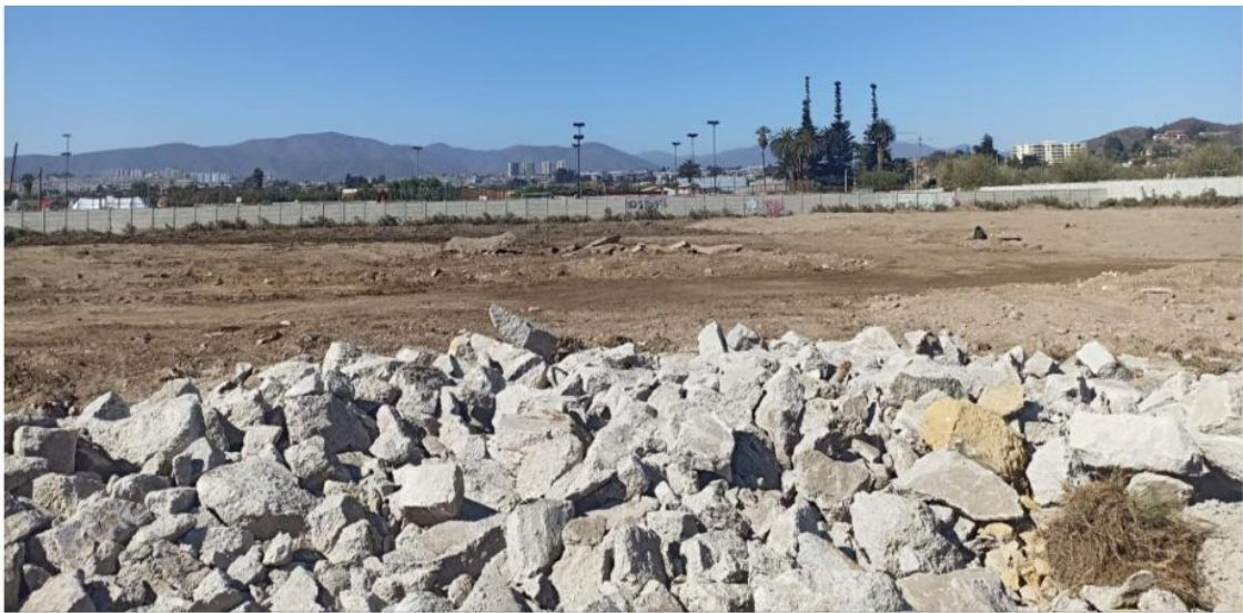
Imagen 3. Fotografías del área intervenida. Se observa presencia de escombros y terrenos nivelados al fondo
